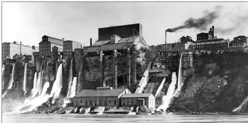
Fig. 4. Central hidroeléctrica de las cataratas del Niágara.
